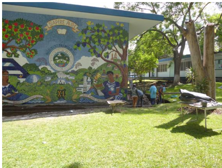
Apoyo en los trabajos del Mural, y construcción de Machuelo con piso de concreto estampado con luminarias de piso tipo led. Con una inversión de $65,750.00
