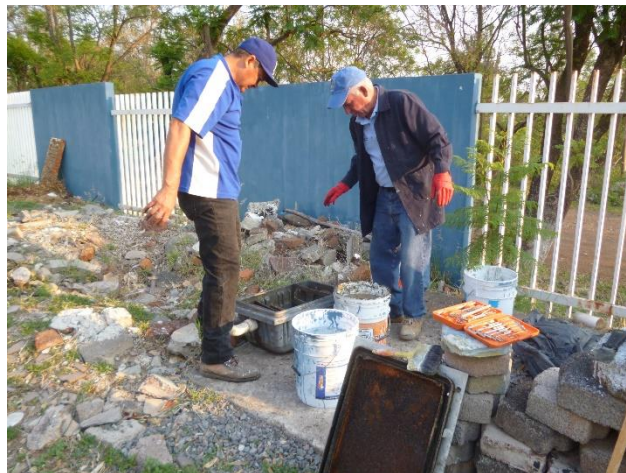
Operaciones de Limpieza de la Trampa de grasas de la lonchería principal.
