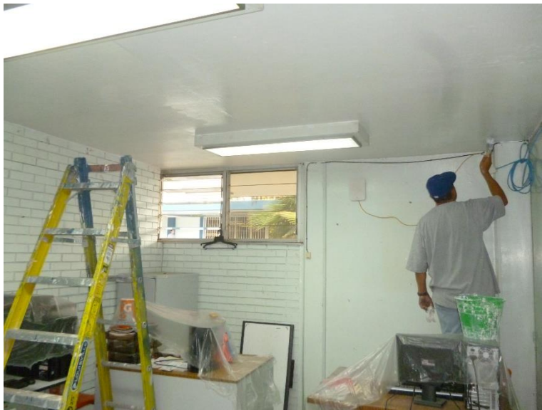
Mantenimiento con Pintura vinílica y esmalte en la Oficina Sindical con sellado de gabinetes eléctricos con una inversión de $ 3,200.00
