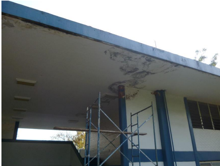
Mantenimiento con Pintura tipo vinílica en plafón del Edificio “E”
