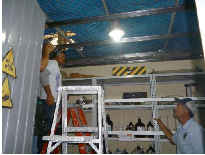
Instalación de plafón con tablarroca y luminaria tipo led en área de reactivos del laboratorio de Operaciones Unitarias. Con una inversión aproximada de $4,800.00
